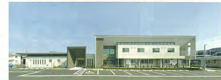
サポートセンター川崎外観。1階の特別養護老人ホーム(右)は、個室から外のテラスに出ることができる
