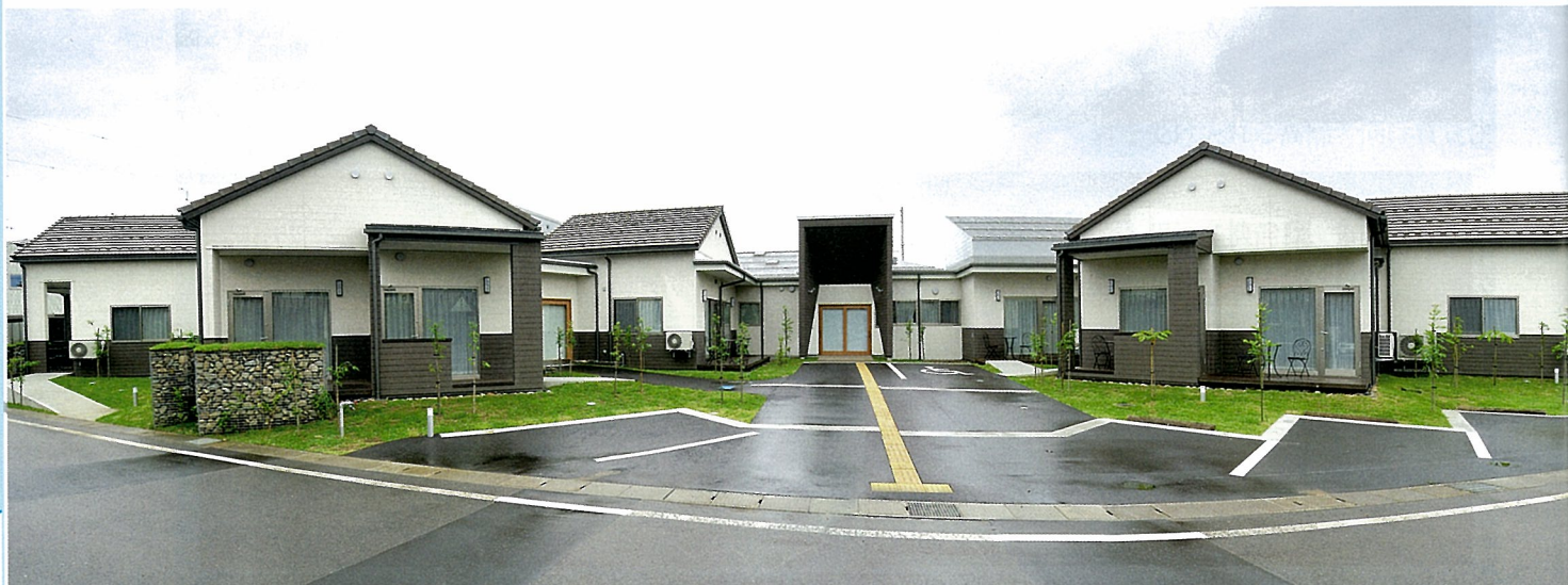
撰田屋の外観。2011年5月に開業。手前両側は小規模特養。奥に小規模多機能型居宅介護施設が見える。この写真には映っていないが、設計者の高田建築事務所が周辺の住宅も設計したため、デザインがそろっている。大きな看板もなく、近隣住宅に溶け込んでいる(写真:高田建築事務所)
