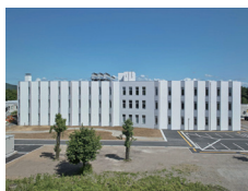
小千谷さくら病院 新病棟
