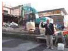
解体される旧事務所と
