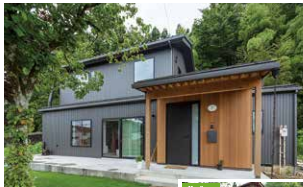
元の建物形状をベースに、ポーチの屋根の架け方を片流れに変えてシンプルに。外壁は耐候性の高いガルバリウム鋼板、壁量を増やし耐震性も向上。
