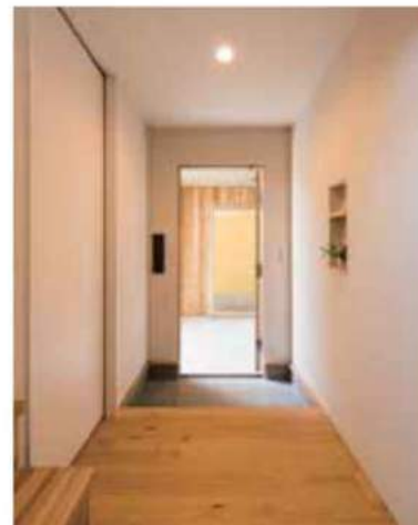
左 / 2階のベランダ。手すりも外壁と同じ木で製作、さらに軒下にも木を張っている 右 / 二世帯住宅の玄関は一つ。玄関ホールにも天然壁材、モイスを採用。天然の鉱物を主成分としているため、土壁や木の素材のように呼吸する
