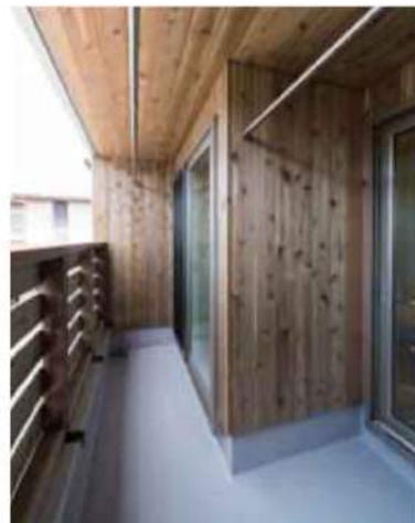
左 / 2階のベランダ。手すりも外壁と同じ木で製作、さらに軒下にも木を張っている 右 / 二世帯住宅の玄関は一つ。玄関ホールにも天然壁材、モイスを採用。天然の鉱物を主成分としているため、土壁や木の素材のように呼吸する
