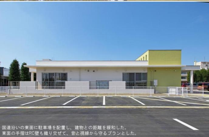
国道沿いの東面に駐車場を配置し、建物との距離を緩和した。東面の手摺はRC壁も織り交せて、音と視線から守るプランとした。
