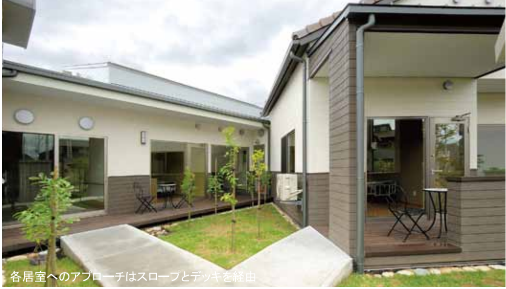
各居室へのアプローチはスロープとデッキを経由
