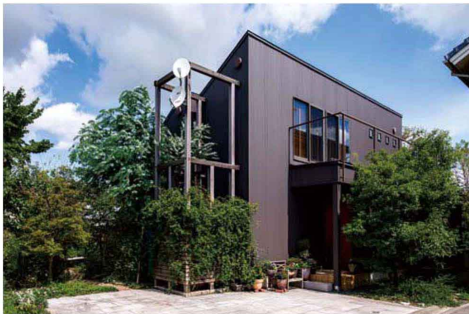
木々の緑をまとった外観が町並みを彩り、美しい景観を創る。写真左に見える煉瓦敷きの小道から庭に繋がる。
