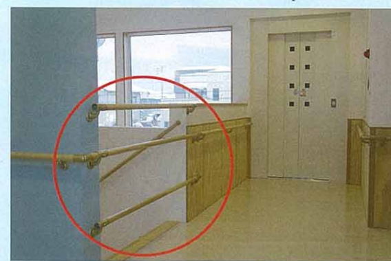
2階のエレベーター前。入居者は主にエレベーターを使用。階段は転落防止のために、取り外しできる木製バーを設置している（丸印）
