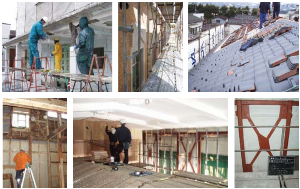
内外装・耐震補強のリノベーション工事
