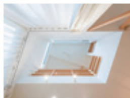
ひし形の吹き抜け
